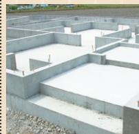
地震や台風時の横からの外力に強い二重張り「剛床工法」。床全体で加重を受けるベタ基礎は、建物が土と遮断されるためシロアリ対策にも有効。
